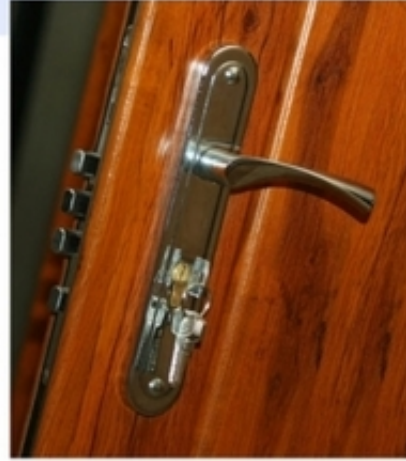
ОСНОВНОЙ ЗАМОК АЛЕКС. ЗАМОК С ЗАЩЕЛКОЙ И ЗАДВИЖКОЙ.
